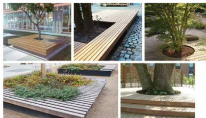
Exemples de callibéris en bois pour permettre l'accès au dessous des jardinières créées pour la conservation des arbres
