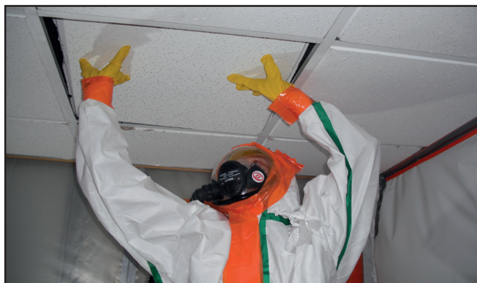
Déplacement de faux-plafond amianté pour intervention
