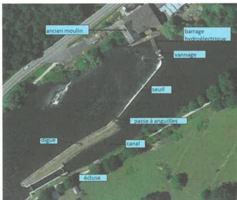
Etat des lieux avant travaux
