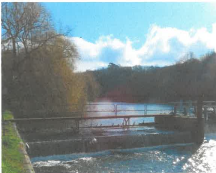
La partie du barrage où seront installées les turbines
