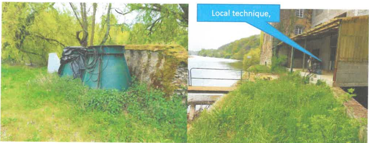
Les anciennes turbines démontées.
