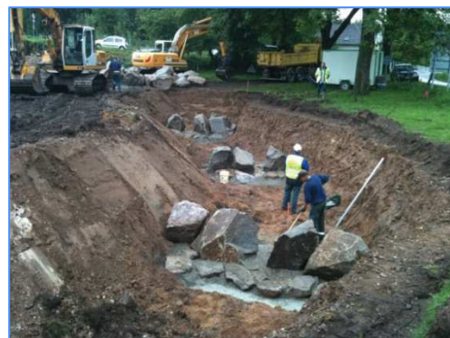
Exemple de réalisation en cours de seuils rustiques sur un bras de contournement.
