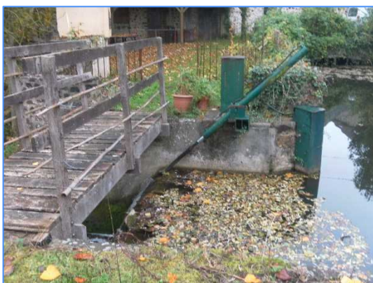
Clapet semi-automatique du Moulin du Bas Écuret
