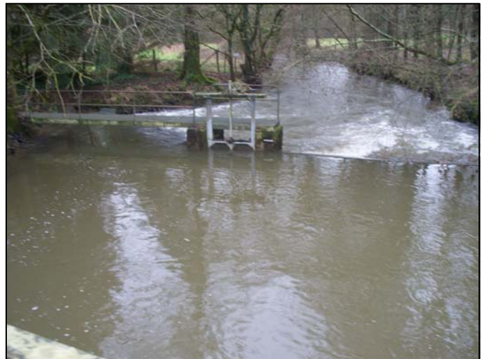
Photo 30 : Vue en aval de l'ouvrage dans le secteur de « Chauverie »
