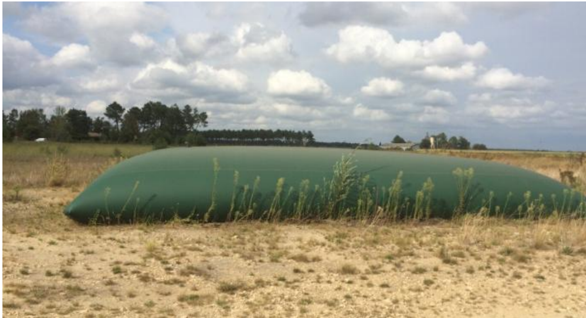
Figure 22 : Exemple de réserve incendie de 120 m3 (Source : Kailher)
