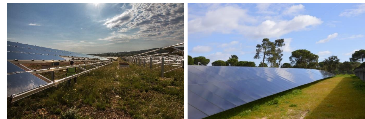
Figure 14 : Exemple de table en cours d'assemblage (gauche) et d'une rangée de modules assemblée sur table (droite)
