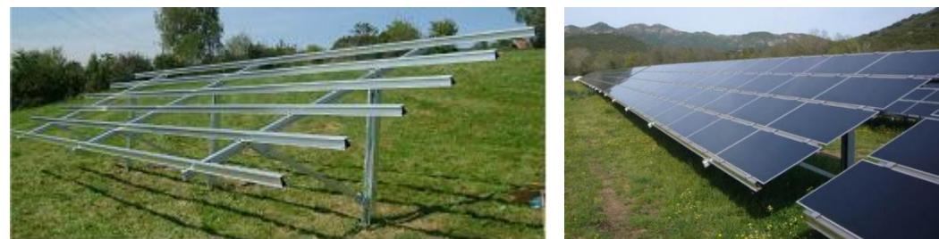
Figure 16 : Exemples d'assemblage d'une table fixe monopieux
