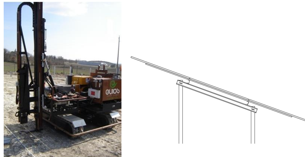
Figure 15 : Engin de battage de pieux à gauche et schéma de principe d'une table bipieux battus dans le sol à droite (Source : Neoen)
