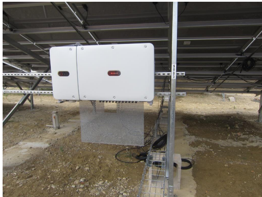
Figure 18 : Exemple d'onduleur décentralisé (Source : Neoen)
