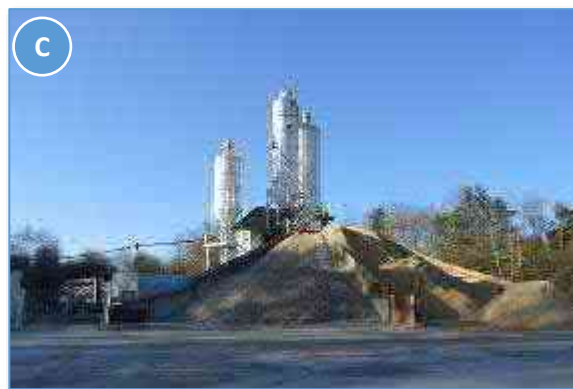
Fig. 7 : Vues sur la centrale à béton Point P
