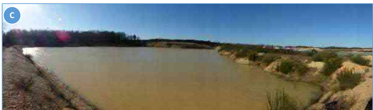
Fig. 21 : Vues sur les bassins de décantation
