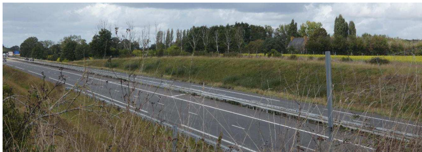
Photo 80 : Autoroute A81, entre le lieu-dit de la Vallée et le Bas Mont Roux (Source : Aepe Gingko)
