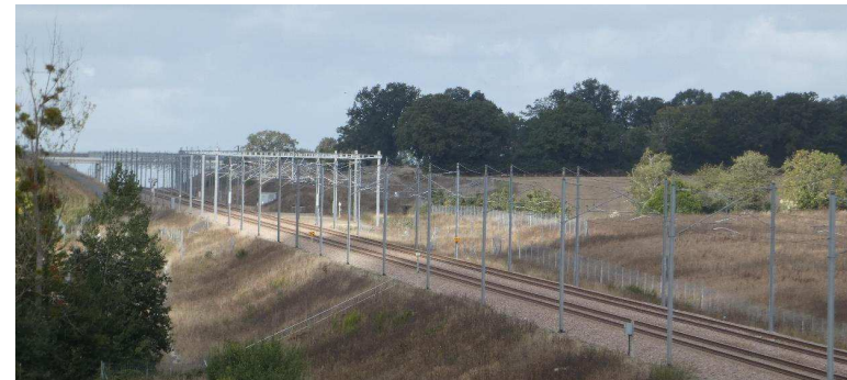
Photo 81 : Ligne LGV, depuis le lieu-dit La Vallée (Source : Aepe Gingko)
