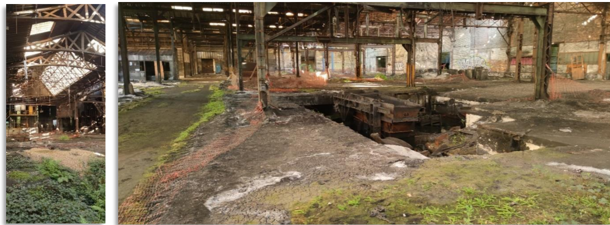
Localisation de l'enregistreur dans le bâtiment n°17, du 13 au 15 juillet 2022, point 2
