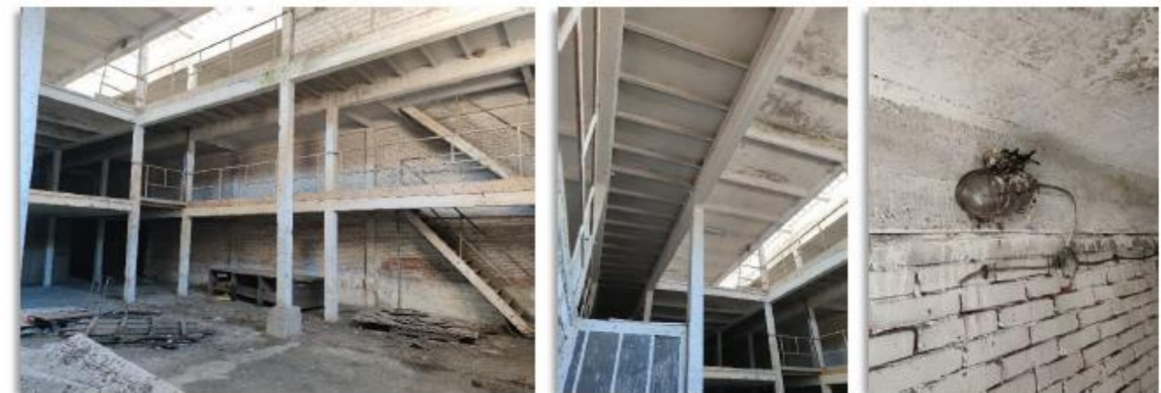
Bâtiment n° 43 où une colonie d'Hirondelles rustiques s'est établie
